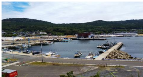
石巻市鮎川港の復興状況
