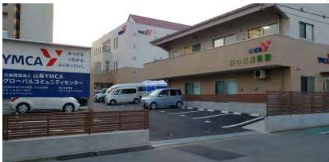
穴山町通りから新会館をのぞむ
